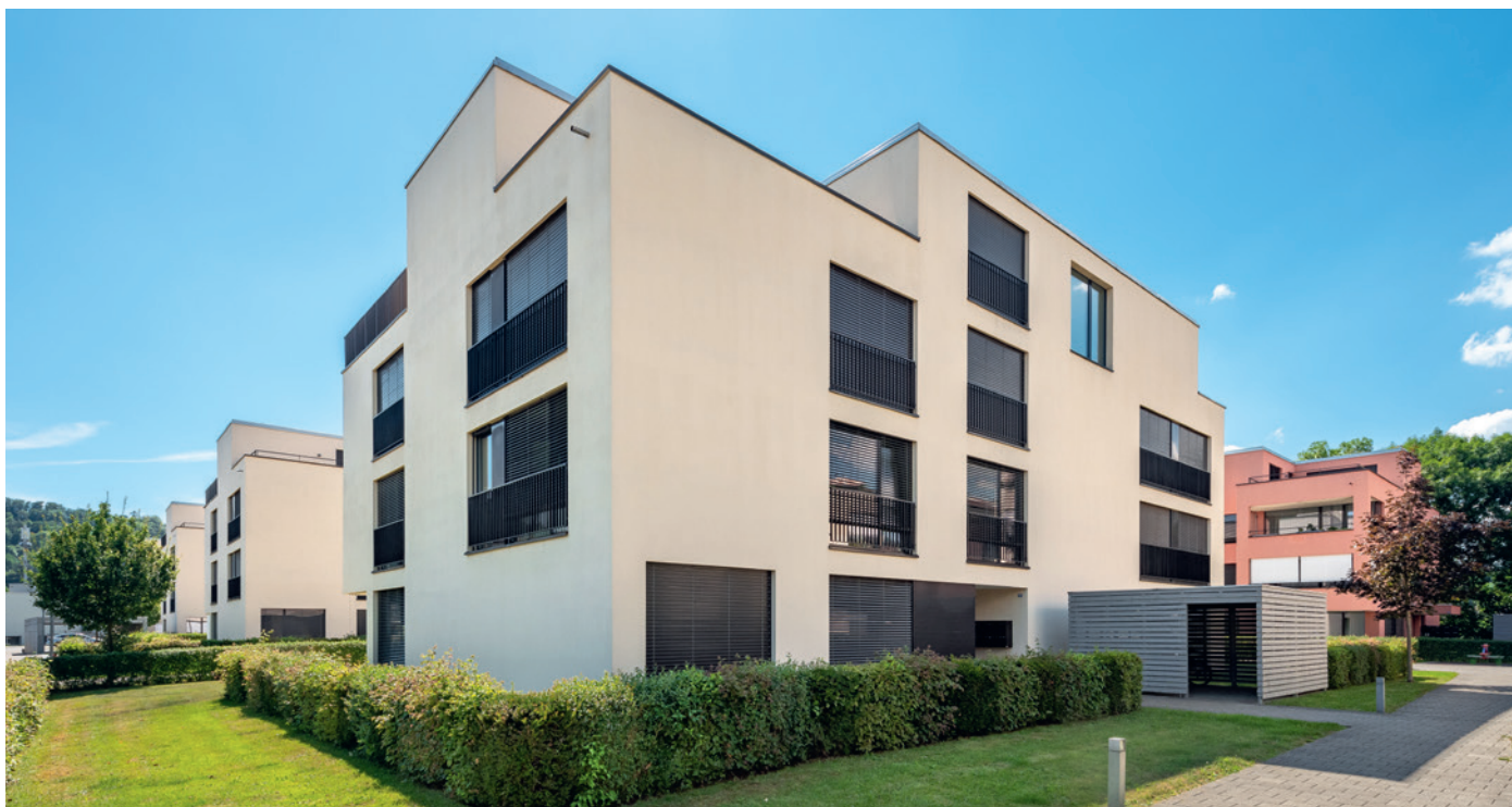
Les bâtiments répondant aux normes Minergie sont chauffés par une pompe à chaleur à sondes géothermiques. Source: Fotowerder
