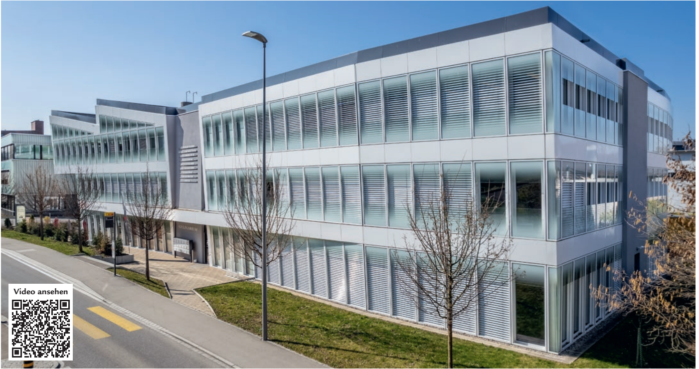
Zu den grössten Mietern gehören ein Fitnesscenter im obersten Stock und ein Restaurant im Erdgeschoss. Quelle: Fotowerder
